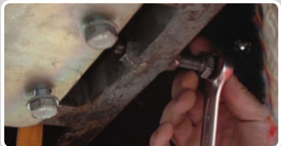
Spænd kontraboltene med en nøgle.
