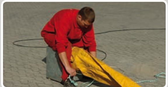
Monter studsene på blæseren.
